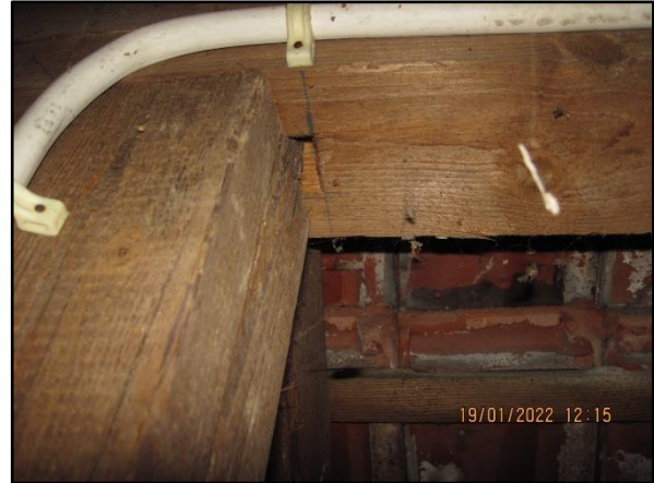
Abb. 16: Zapfenloch im Dachstuhl des Garagengebäudes
