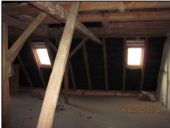
Abb. 21: Dachstuhl des Mehrfamilienhauses
