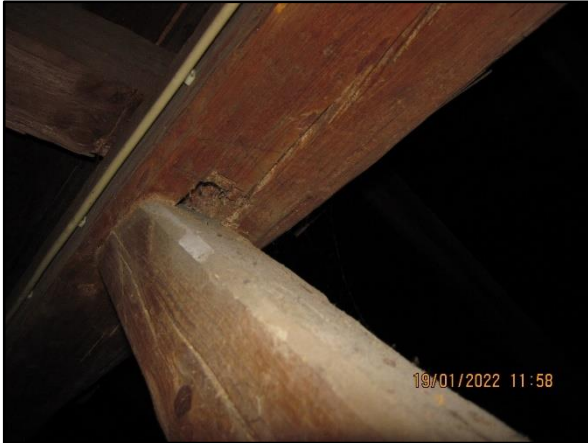
Abb. 15: Zapfenloch im Dachstuhl des Mehrfamilienhauses
