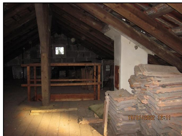
Abb. 24: Dachstuhl des Geragengebäudes
