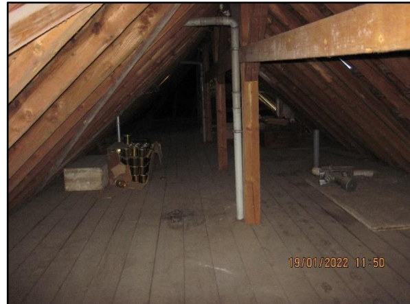
Abb. 22: Dachstuhl des Mehrfamilienhauses
