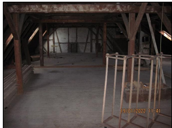
Abb. 20: Dachstuhl des Mehrfamilienhauses
