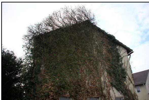
Abb. 7: Mit Efeu bewachsene Wand des nördlichen Gebäudes
