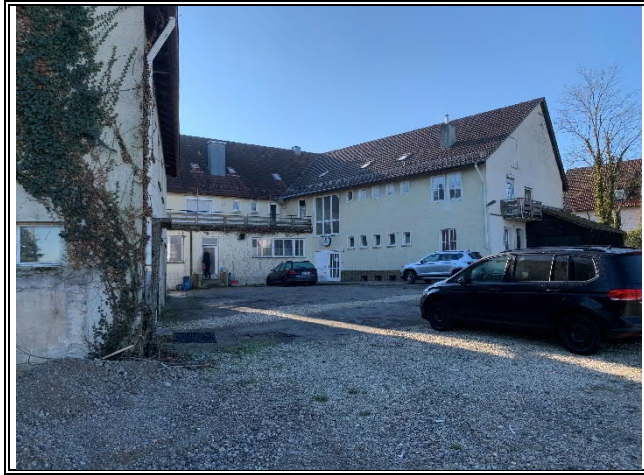
Ansicht des südlichen Standortbereiches
