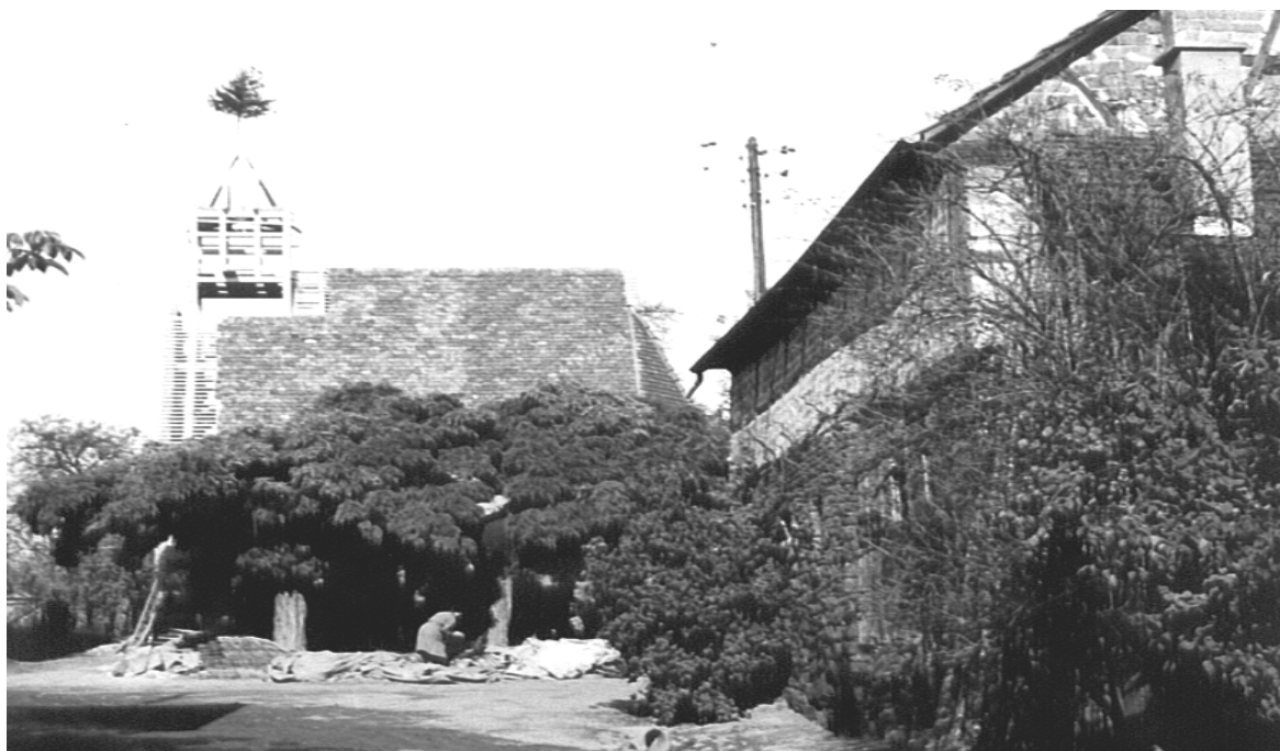
Bauarbeiten an der Kirche in Krummhardt
